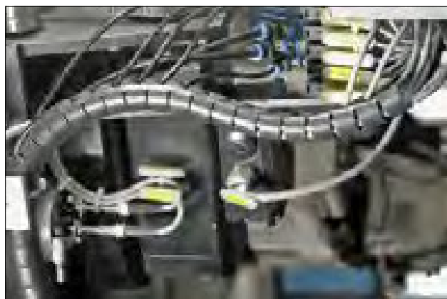
Elastyczny na całej długości węz, umożliwia wykonanie odgałęzień w dowolnym miejscu.
