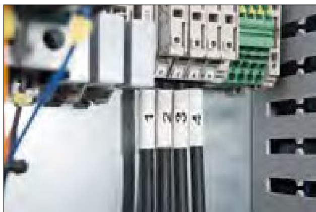
Oznaczniki termokurczliwe TLFD DS - bezpieczne i przejrzyste oznaczenie szaf rozdzielczych.
