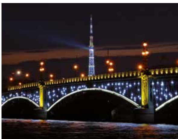
St. Petersburg, Rosja Wieża telewizyjna i Most Św. Trójcy 9.500 lamp błyskowych Pfannenberg
