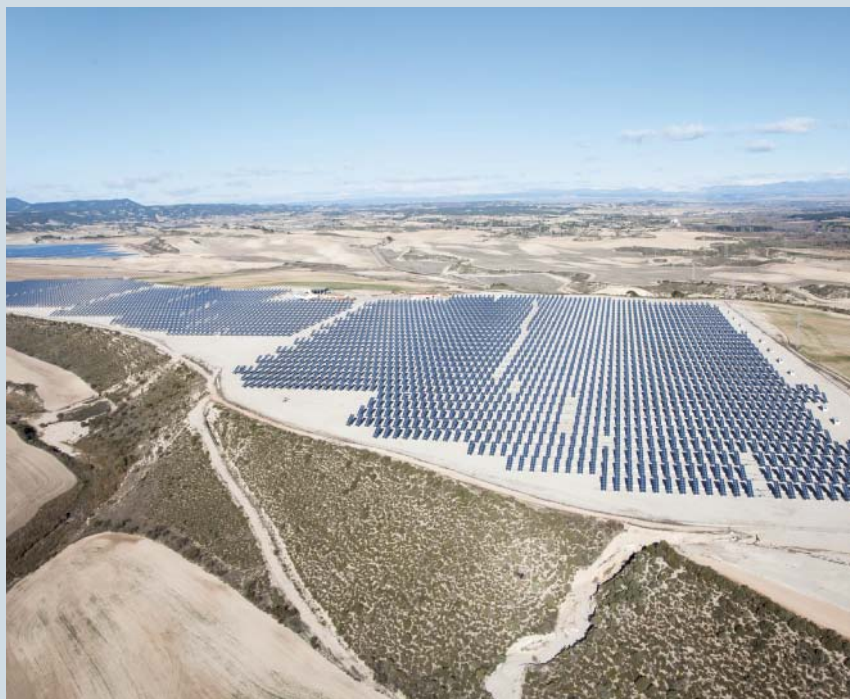
Megawatowa elektrownia słoneczna Zuera II pod Saragossą
