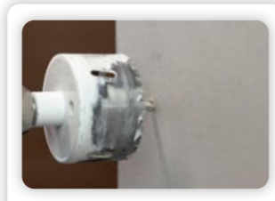
5 Wywiercić w określonym miejscu otwór po przeciwległej stronie za pomocą otwornicy. Pogłębić otwór na puszkę.
