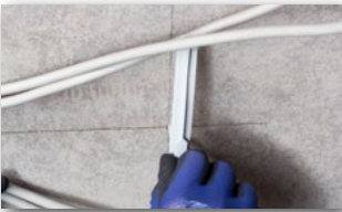
2 Produkt można montować bez dodatkowych narzędzi.
