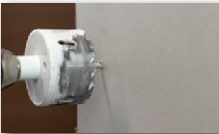
5 Wywiercić w określonym miejscu otwór po przeciwną stronę za pomocą otwornicy; pogłębić otwór na puszkę.
