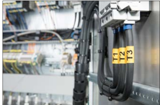
Oznaczniki termokurczliwe TLFD DS - bezpieczne i przejrzyste oznakowanie szaf rozdzielczych.
