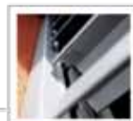
Każda lamela zamocowana jest indywidualnie z obu stron
