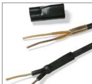
Zastosowanie kleju HMT200A do uszczelnienia kształtki termokurczliwej.
