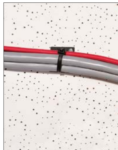
3. Instalacja jest gotowa, Q-tie może zostać zaciągnięta do końca, a zbędny koniec obcięty - zarówno ręcznie jak też przy pomocy narzędzia montażowego.
