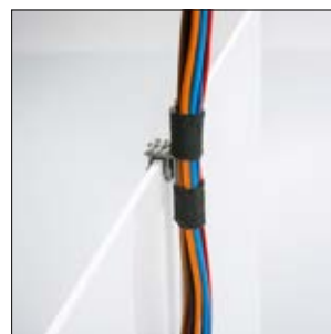
EC17 - Przewody mogą być zamocowane do elementu mocującego przy pomocy opasek kablowych lub taśmy.
