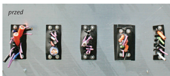
Uszczelnienia ogniowe skierowane ku stronie ognia:
