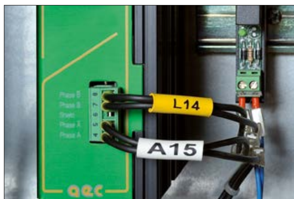
TCGT - oznaczniki termokurczliwe w formie ciągłej rurki, z możliwością dwustronnego nadruku.
