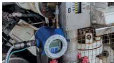
Połączenie sensorów poziomu płynu. (Szanghaj, Chiny) Serie TH451.
