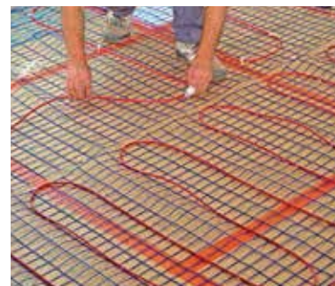
Łączenie kabli grzewczych.
