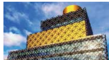
Połączenia urządzeń oświetleniowych na fasadzie biblioteki w Birmingham. (UK) Serie TH405/TH631.
