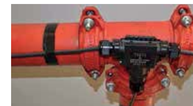
Połączenie pomiędzy kablami grzewczymi. (Francja) Serie TH211.
