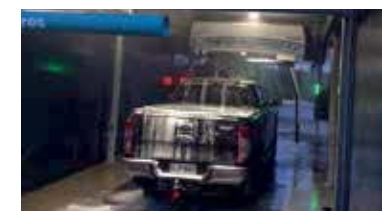
Połączenie punktów oświetleniowych w myjni samochodowej. (Nowa Zelandia) Serie TH387.
