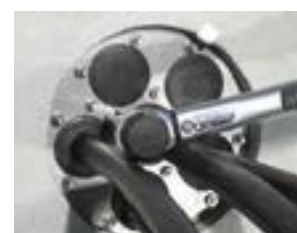
Dokręć nakrętki. Gotowe! Wodoszczelny do 5 barów.
