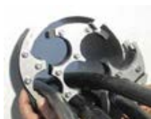
Wyjmij wkładki segmentowe i zainstaluj otwarty przepust wokół kabli.
